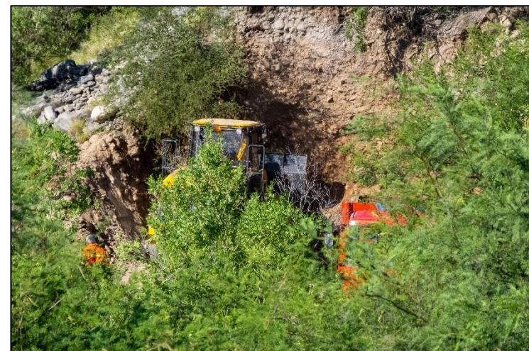
Foto N°11: Máquinas trabajando en una cantera situada en la etapa D.
